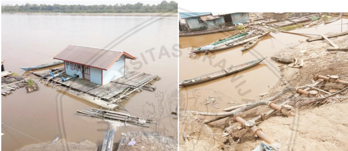
Gambar 3.2. Sumber Air Sungai Barito dan Intake IPA BNA Barsel
