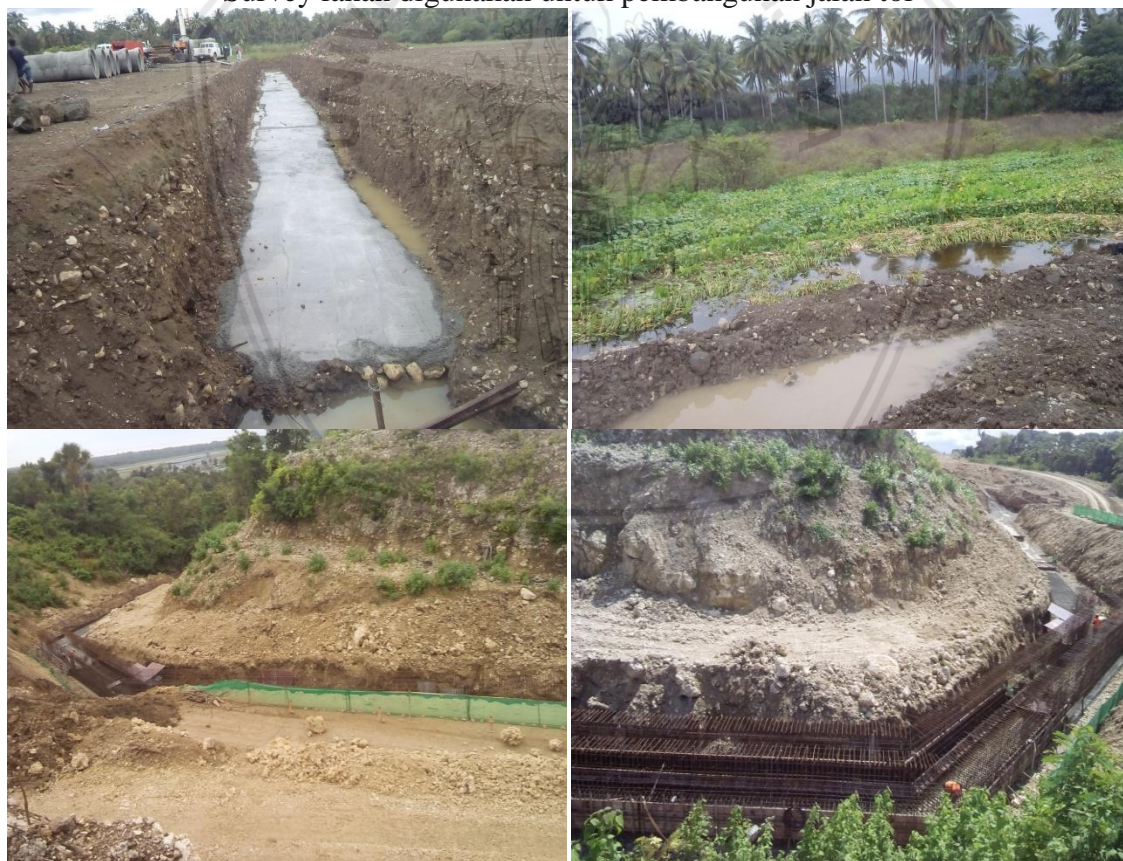
Pekerjaan awal proyek jalan tol baru
