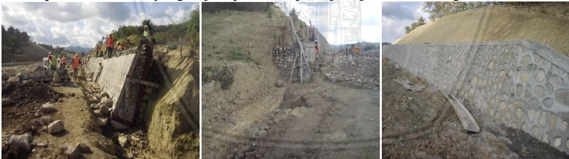
Pekerjaan Tembok penahan
