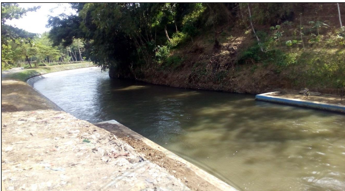
Gambar 3.7. Saluran primer Jaringan Irigasi Molek Sumber: Dokumentasi Lapangan
