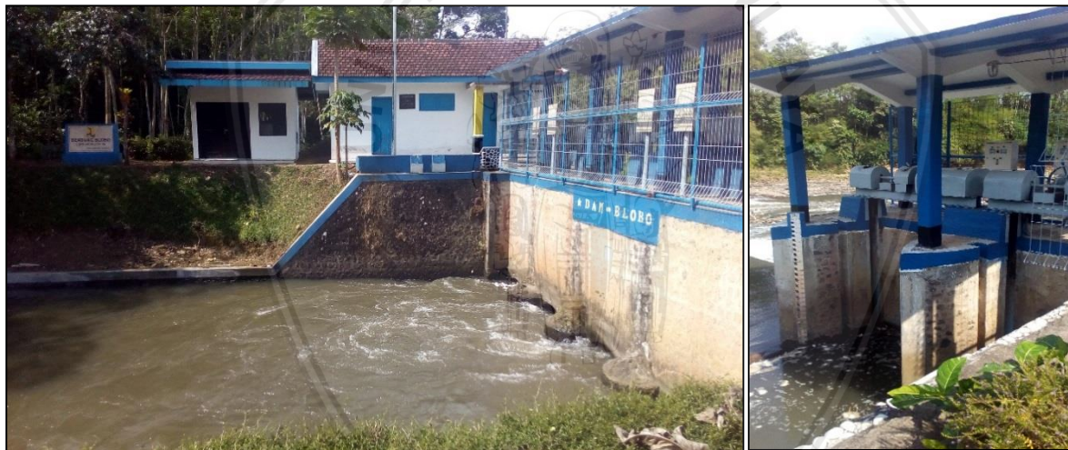
Gambar 3.6. Pintu intake (kiri) dan pintu pembilas (kanan)
