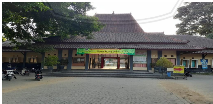
Lampiran 3. Tampak Depan Destinasi Kolam Renang Penataran Sumber : Dokumentasi Peneliti, 2019.
