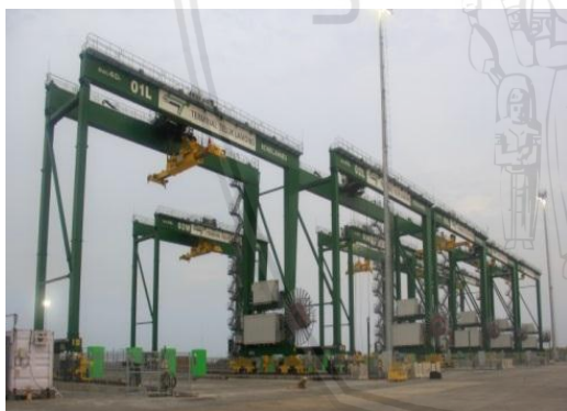
Gambar 4.12 Automated Stacking Crane (ASC) pada PT Terminal Teluk Lamong Sumber: www.terminalteluklamong.co.id (diakses pada tanggal 8 Januari 2019)
