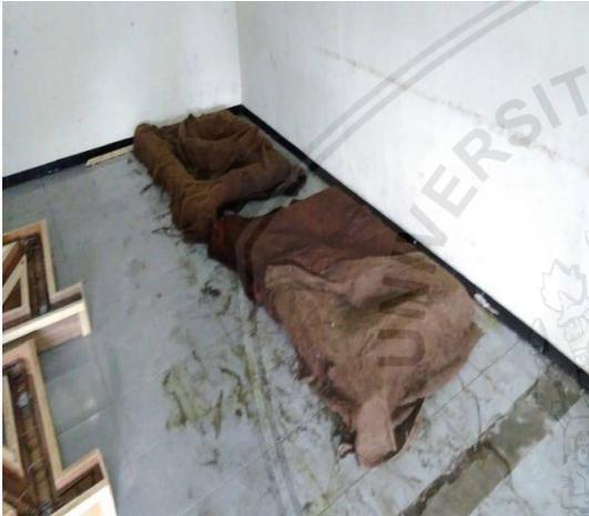
Gambar L 4.14 Curing dengan menggunakan garung goni
