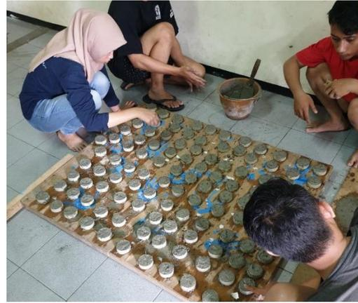
Gambar L 4.4 Proses pembuatan beton decking
