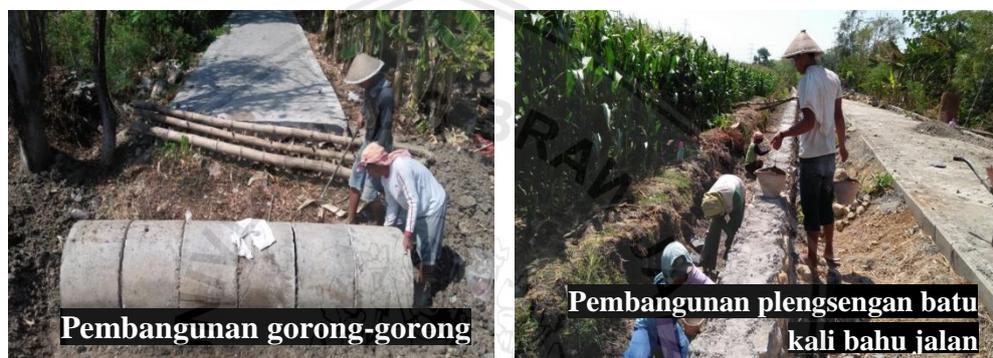
Gambar 14. Pembangunan gorong-gorong dan plengsengan batu kali bahu jalan
