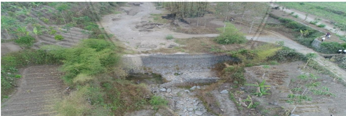
Gambar 4.5 Tampak Atas Check Dam 01 Kali Serinjing
