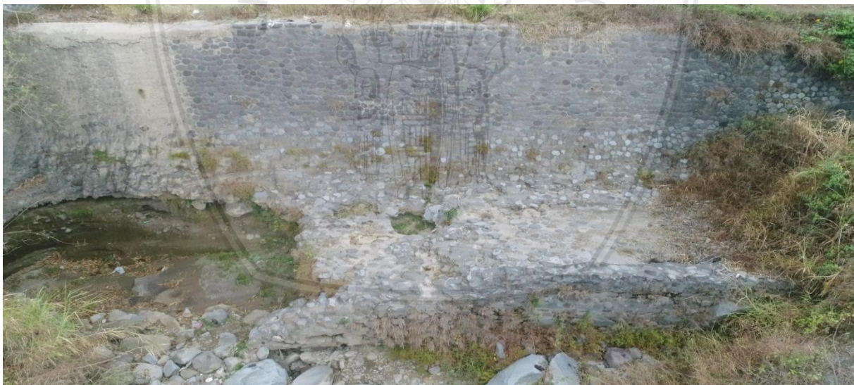
Gambar 4.7 Kondisi Apron Check Dam 01 Kali Serinjing Sumber: Hasil Survei Lapangan
