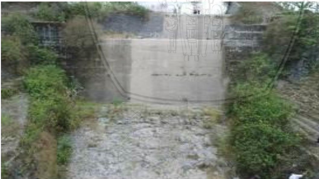
Gambar 4.17 Kondisi Eksisting Check Dam 02 Kali Serinjing Sumber: Hasil Survei Lapangan
