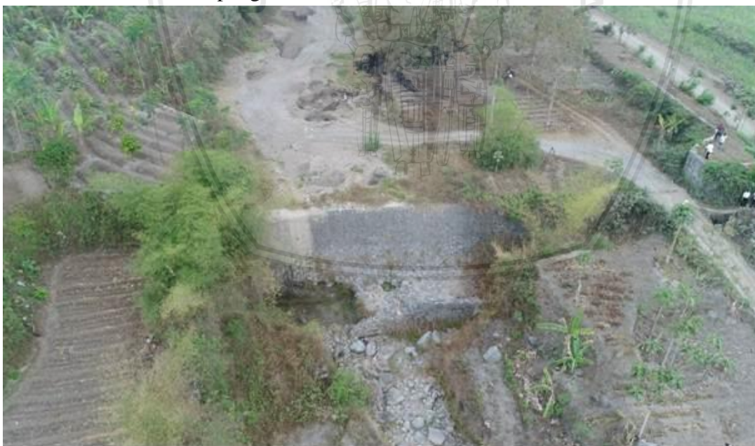
Gambar 4.15 Kondisi Eksisting Check Dam 01 Kali Serinjing Sumber: Hasil Survei Lapangan
