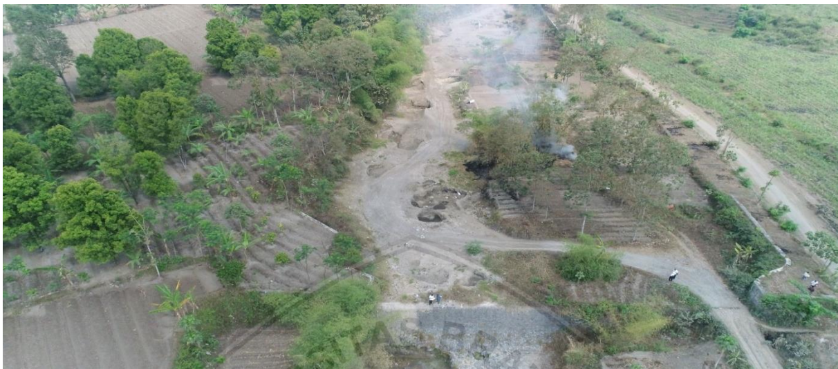
Gambar 4.6 Bagian Hulu Check Dam 01 Kali Serinjing Sumber: Hasil Survei Lapangan
