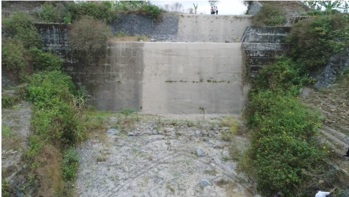
Gambar 4.12 Apron Hilir Sub Dam Check Dam 02 Kali Serinjing Sumber: Hasil Survei Lapangan
