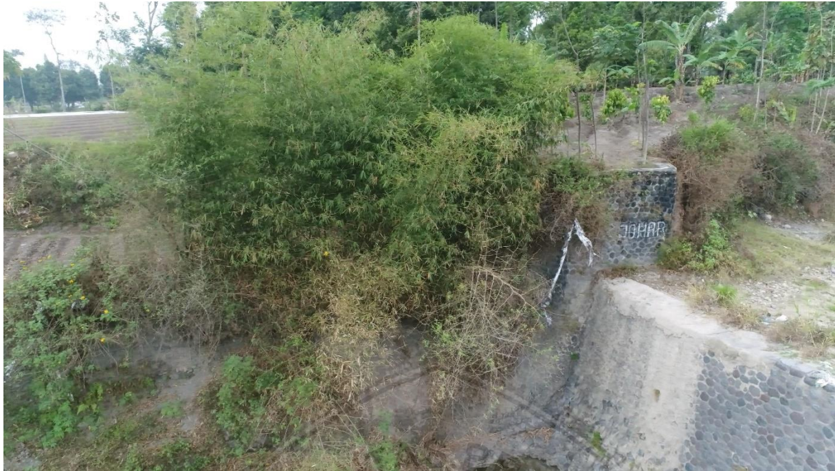
Gambar 4.8 Kondisi Dinding Pelindung Tebing Check Dam 01 Kali Serinjing Sumber: Hasil Survei Lapangan
