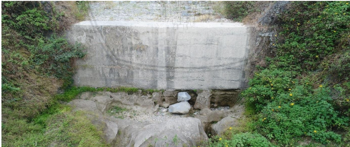
Gambar 4.13 Kondisi Eksisting Sub Dam Check Dam 02 Kali Serinjing Sumber: Hasil Survei Lapangan
