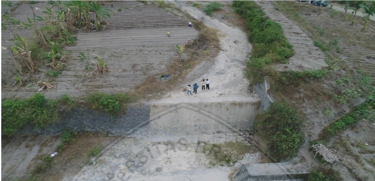
Gambar 4.10 Bagian Hulu Check Dam 02 Kali Serinjing Sumber: Hasil Survei Lapangan
