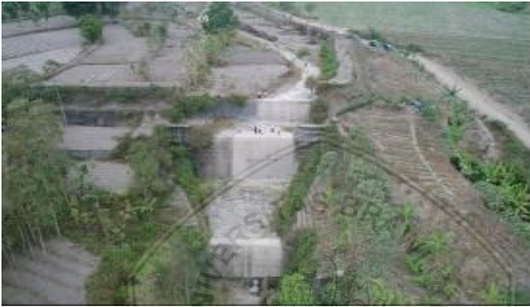
Gambar 4.16 Kondisi Eksisting Check Dam 02 Kali Serinjing Sumber: Hasil Survei Lapangan
