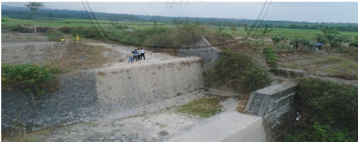
Gambar 4.11 Apron Hilir Main Dam Check Dam 02 Kali Serinjing Sumber: Hasil Survei Lapangan
