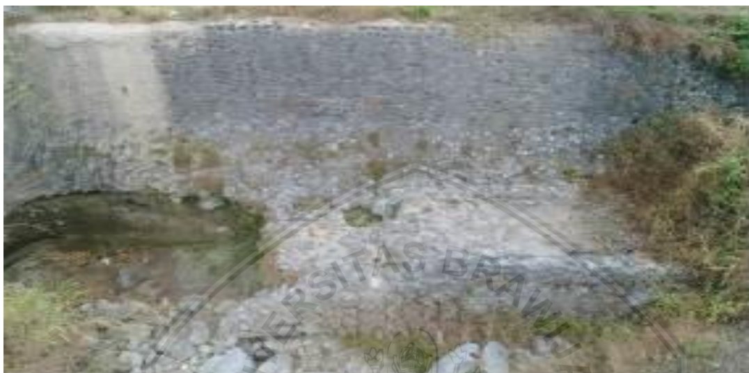
Gambar 4.14 Kondisi Eksisting Check Dam 01 Kali Serinjing Sumber: Hasil Survei Lapangan
