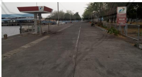
Gambar 15. Kondisi Jalan PPP Mayangan
