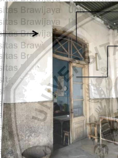
Gambar 4.34 Pintu P1 Kedai Kopi Teridentifikasi masih asli dan tidak mengalami perubahan
