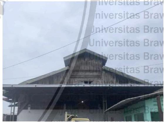
Gambar 4.54 Bovenlicht pada Gevel Peron Lintasan KA sisi Selatan
