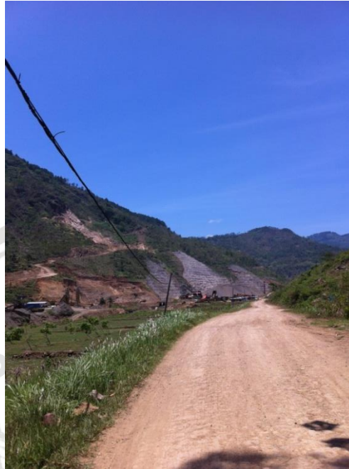
Gambar 2.5 Kondisi Jalanan Menuju Bendungan
