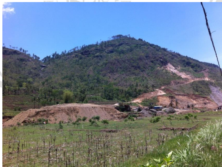
Gambar 2.4 Lahan Pembangunan Bendungan Tugu
