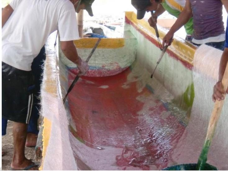
**Gambar 7.** Pelapisan matt dan resin yang dilakukan pada jukung *Fiberglass*.
