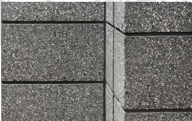
Gambar 3.6 Dinding yang sudah digosok (dipoles)
