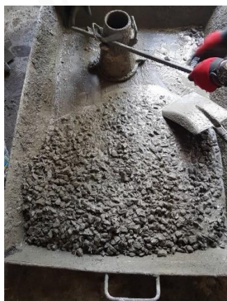
Gambar 4.3 Proses pencampuran material beton
