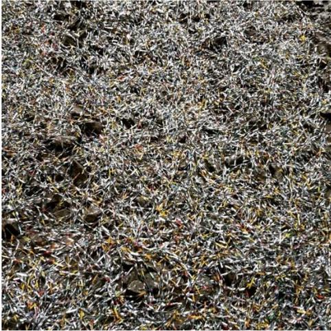
Gambar 4.4 Proses pencampuran serat ke dalam campuran beton
