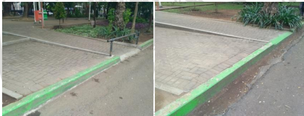
Gambar 4.49Ramp pada Pintu Masuk Plaza Utama
