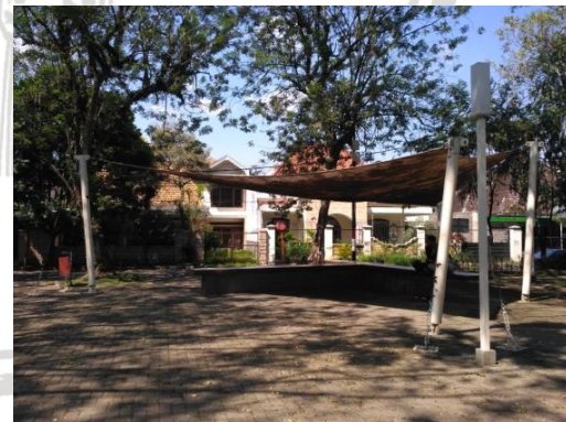
Gambar 4.9 Kondisi Eksisting Shelter
