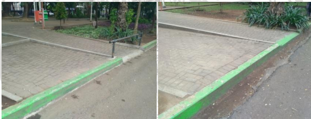
Gambar 4.49 Ramp pada Pintu Masuk Plaza Utama
