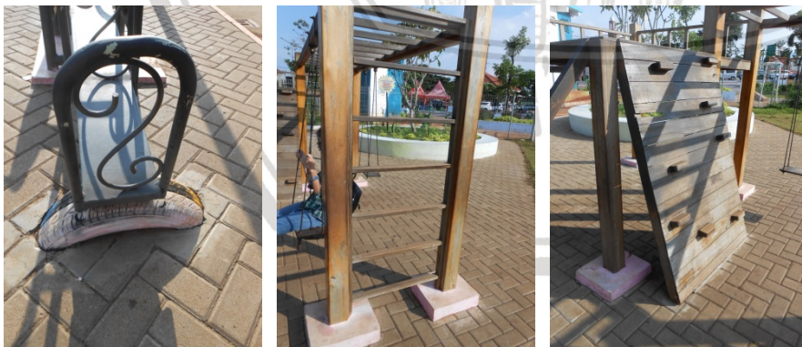
Gambar 4.6 Kondisi alat permainan yang kurang baik
