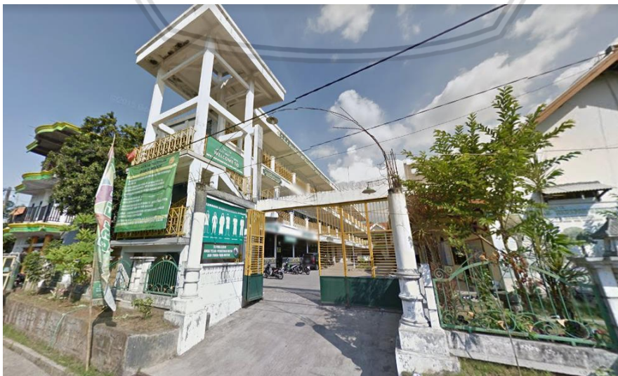
Gambar 4.3 Tampak Depan Bangunan
