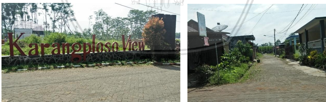
Gambar 4.1 Foto Kawasan Perumahan Karangploso View
