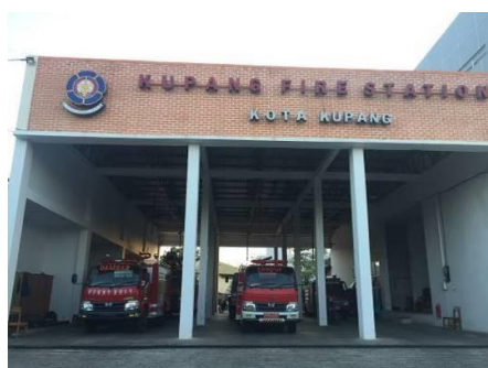
Gambar 4.33 Pos Pemadam Kebakaran Kota Kupang
