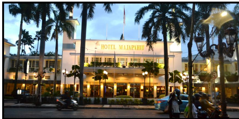
Gambar 4. 41 Penerangan pada Exterior Bangunan
