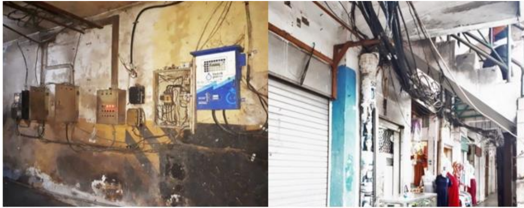
Gambar 4. 53 Kondisi eksisting pemasangan kabel
