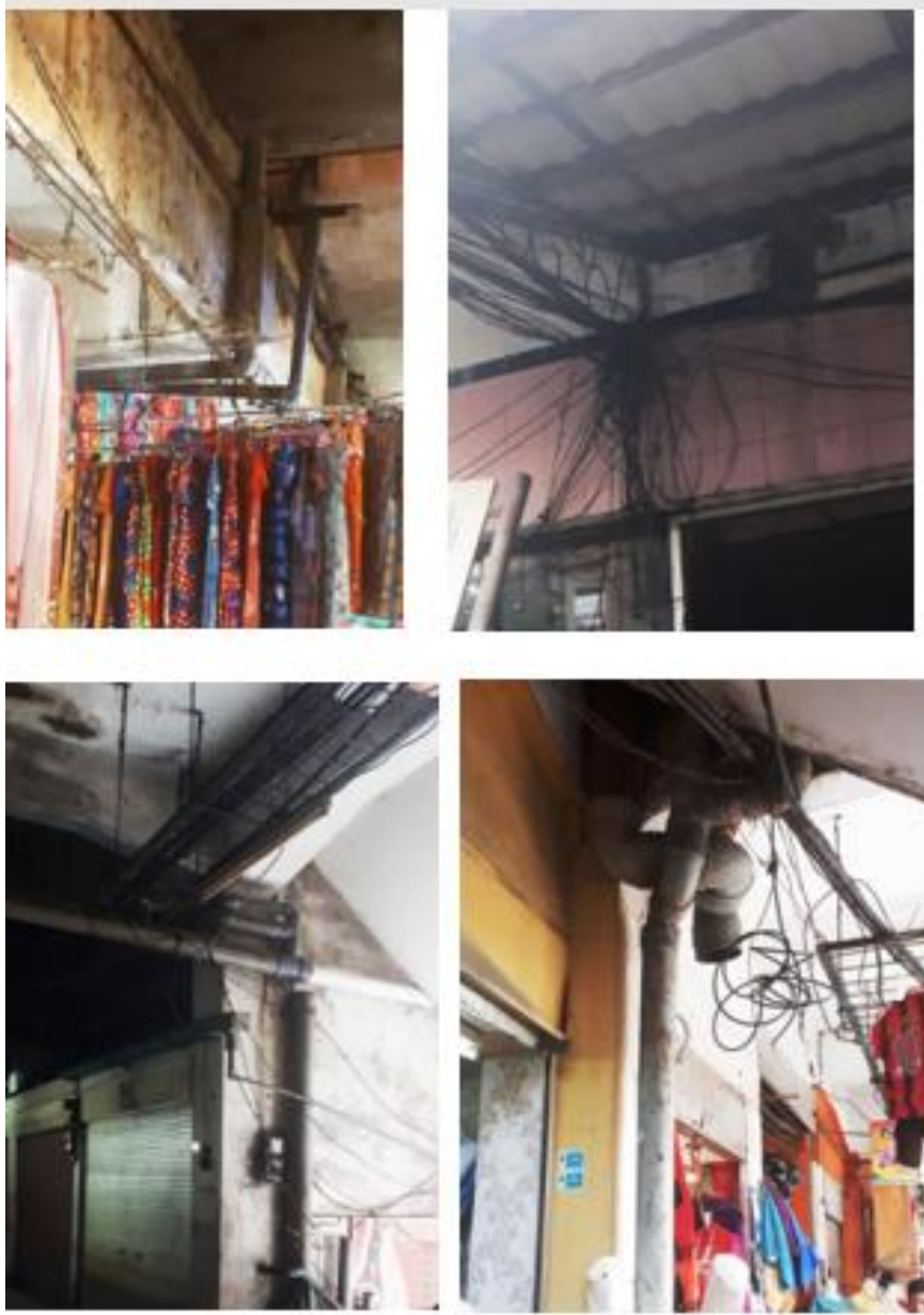
Gambar 4. 56 Kondisi eksisting penataan kabel
