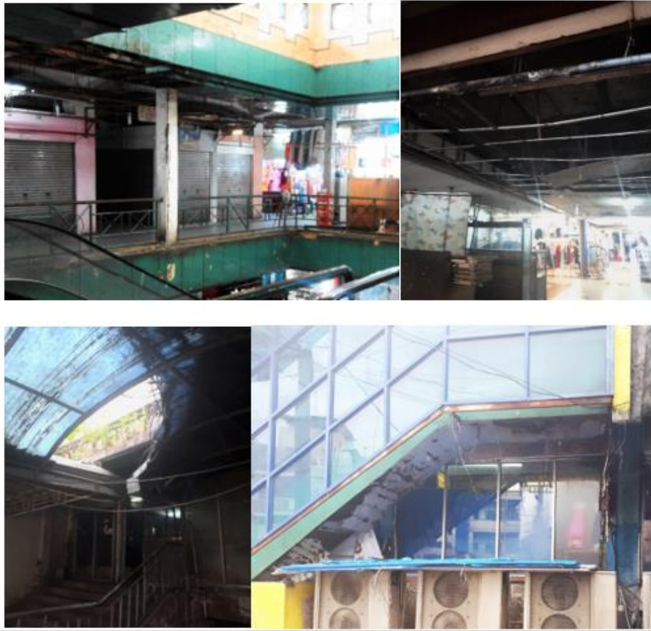
Gambar 4. 54 Kondisi eksisting struktur bangunan
