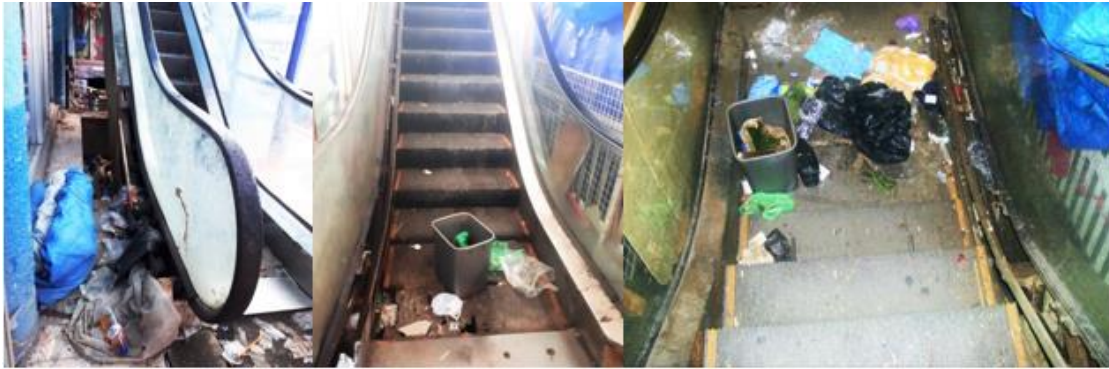
Gambar 4. 21 Kondisi eksisting eskalator
