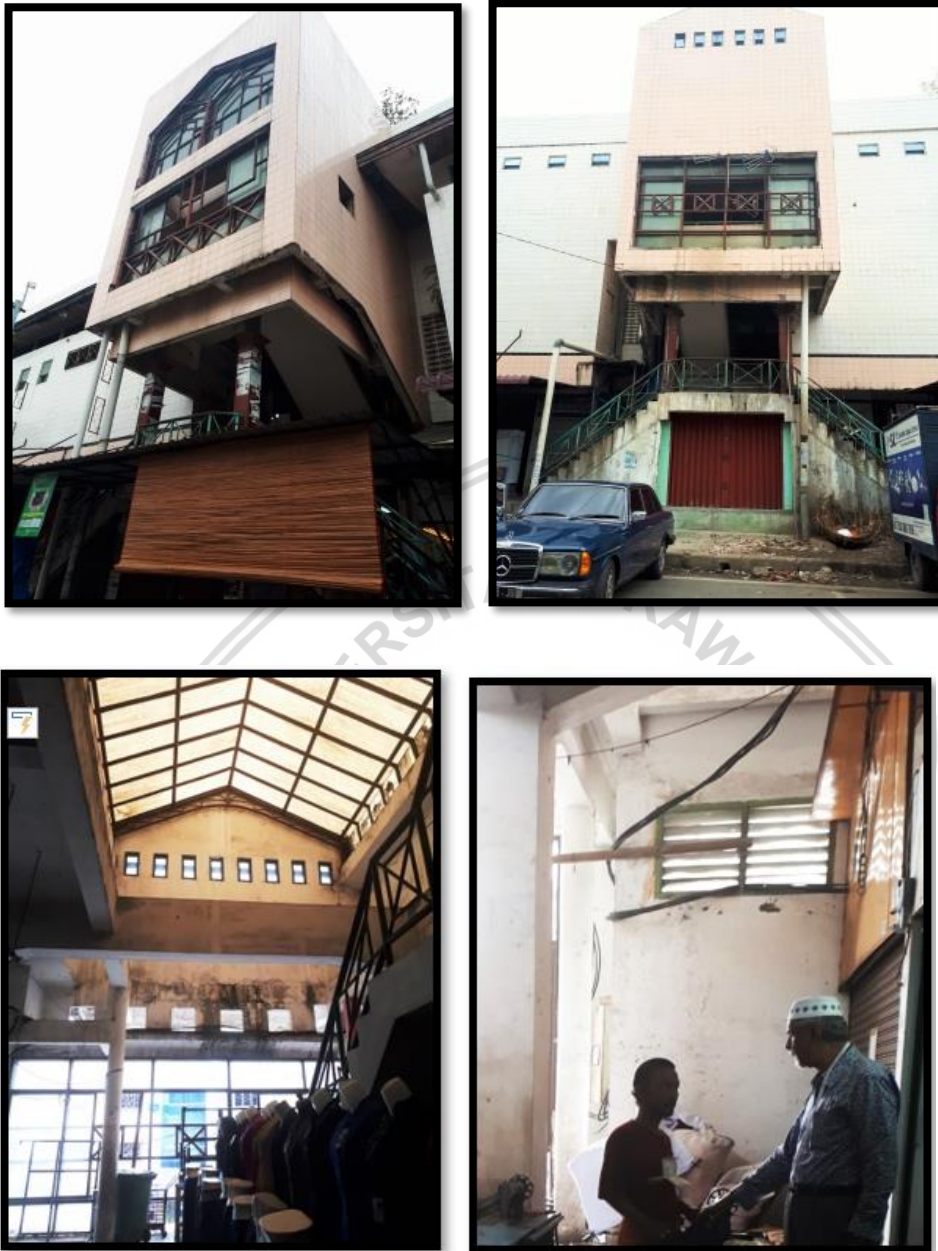
Gambar 4.55 Kondisi eksisting bukaan bangunan
