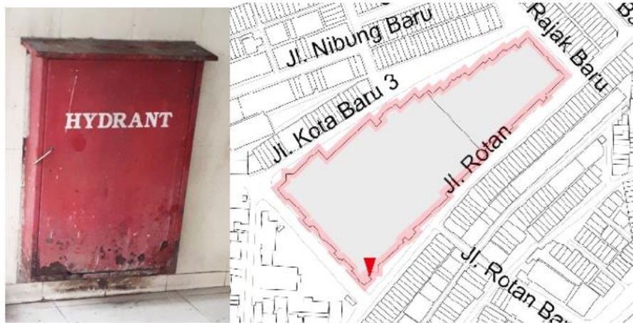
Gambar 4. 51 Kondisi eksisting hidran gedung
