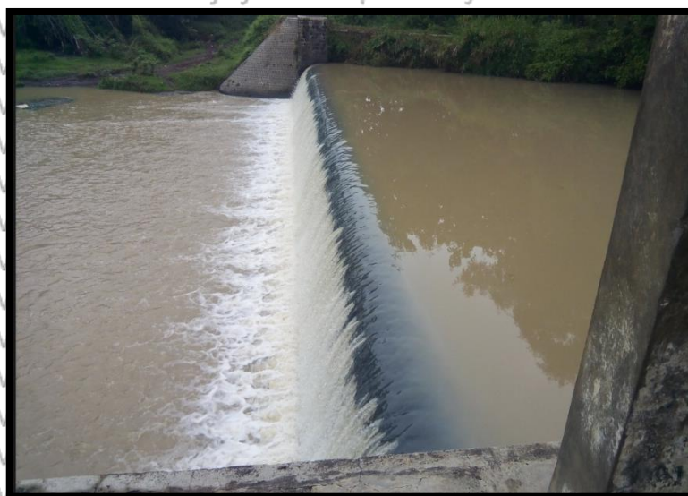
Gambar 3. 2. Bendung Kedung Putri tampak samping pada tanggal 8 Mei 2015 Sumber : Dokumentasi hasil survei
