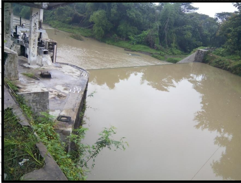
Gambar 3. 3. Bendung kedung Putri tampak depan pada tanggal 8 Mei 2015
