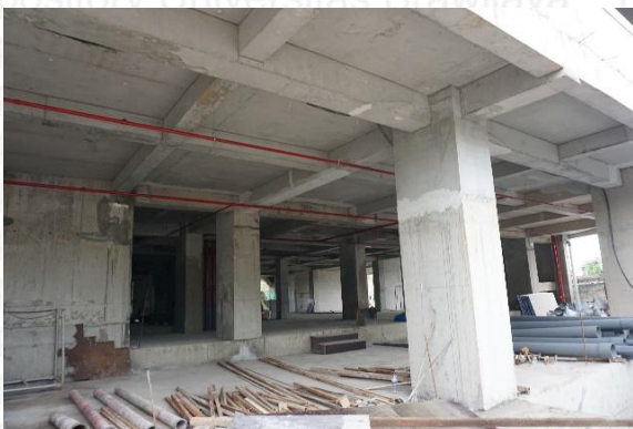
Progress pengerjaan lantai dasar
