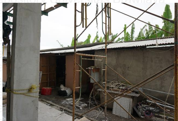
Area gudang dan toilet tukang
