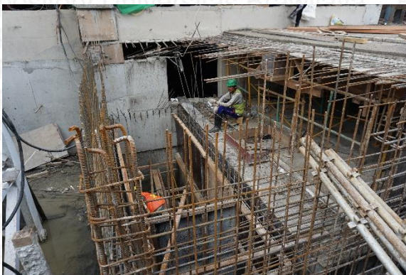
Progress pengerjaan GWT
