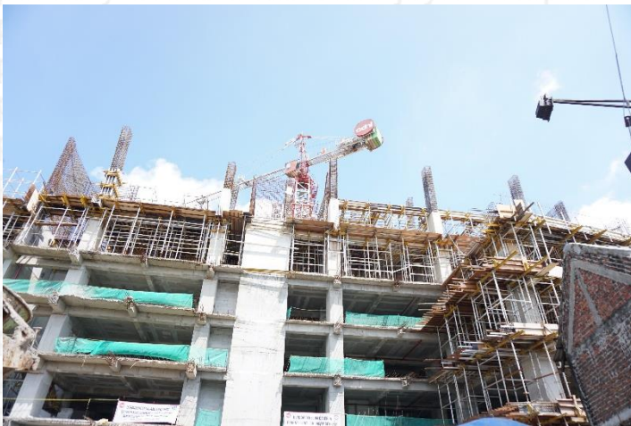
Kondisi proyek yang sudah mencapai tahap pengerjaan struktur lantai ke tujuh.
