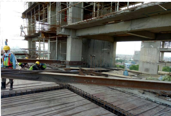
Progress pengerjaan ramp
