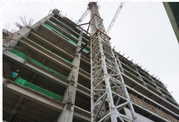
Progress proyek yang sudah mencapai pekerjaan struktur lantai ke 12
