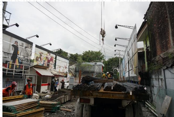
Pekerjaan bongkar muat
