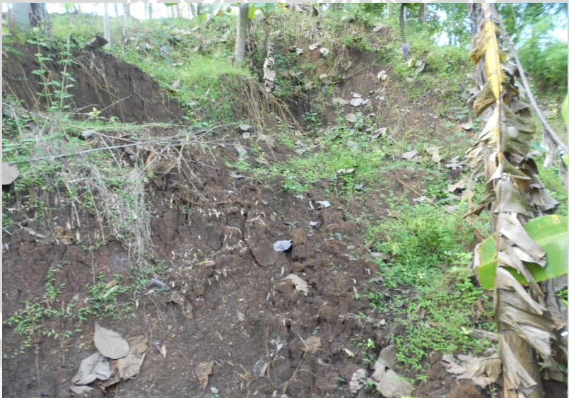
Gambar L6. Kondisi tanah yang rekah-rekah dan mudah bergerak.
