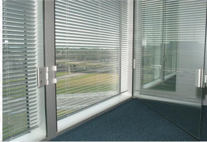
Gambar 2.14 Tirai Dalam pada Sistem Fasade Ganda Mekanis (*Storey Facade with Juxtaposed Modules*)
