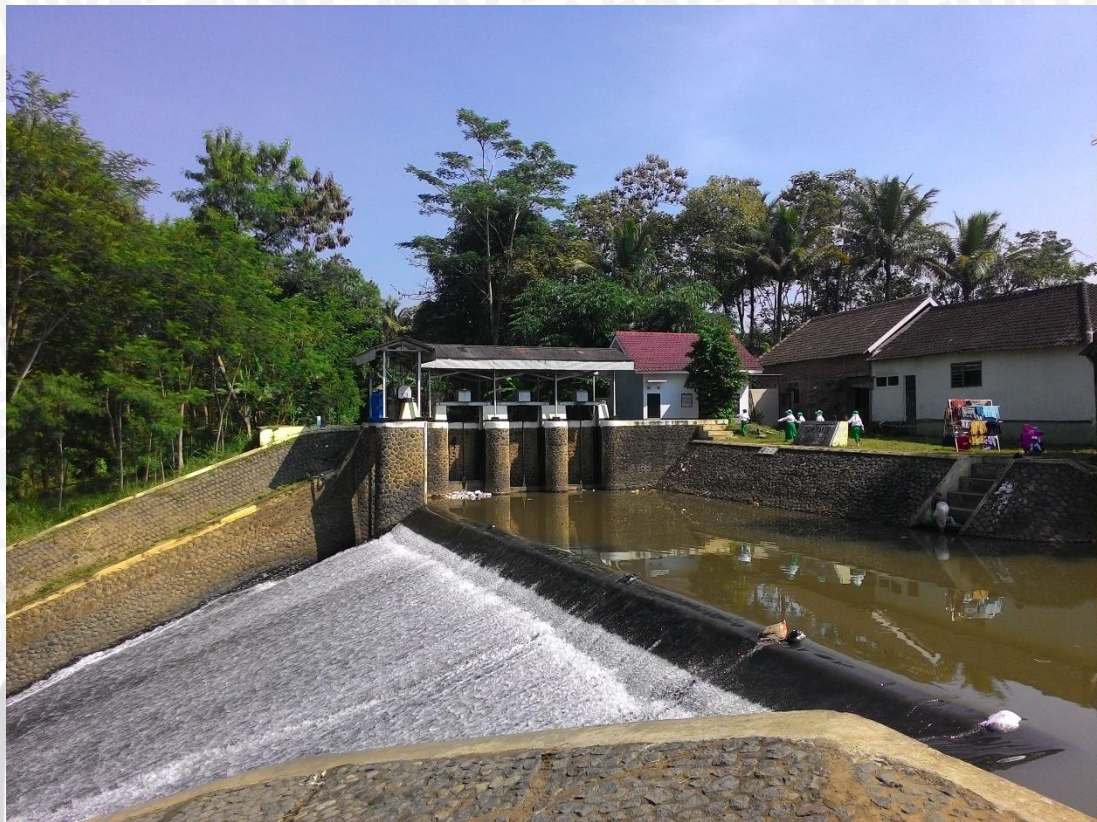
Gambar 3.6 Dam Pakis Sumber : Dokumentasi Lapangan
