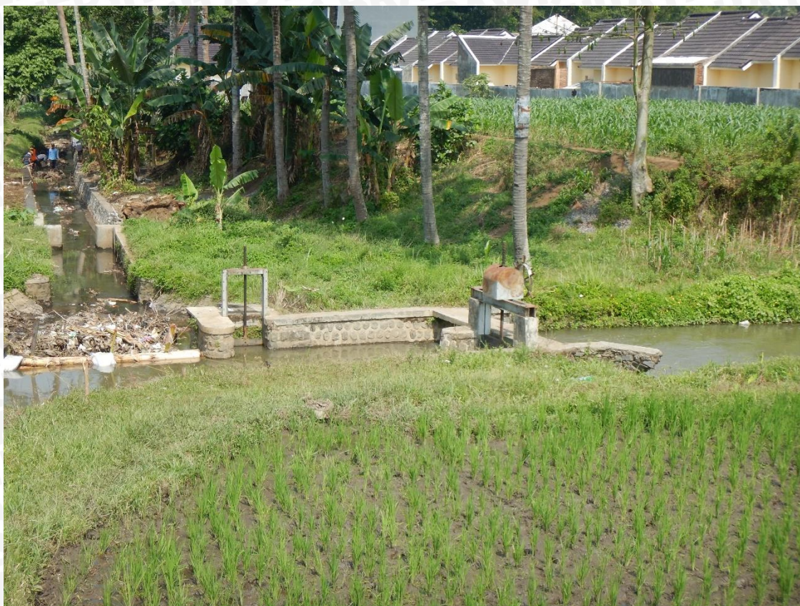
Gambar 3.8 Bangunan Bagi B. PK 2 Sumber : Dokumentasi Lapangan
