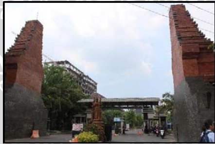
Gambar 4.180 Kondisi Visual Gerbang dan Gapura Node 19
