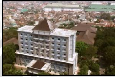
Gambar 4.201 Kondisi visual Gedung FPIK Sumber: R. Hafinudin, 2016
