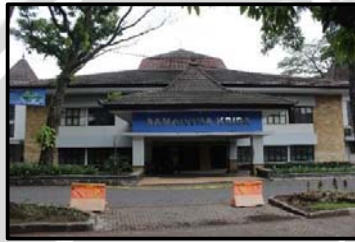
Gambar 4.189 Kondisi visual Gedung Sakri
