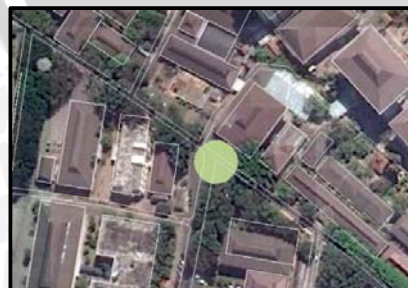
Gambar 4.152 Lokasi Node 1 Tampak Atas Sumber: Google Earth, 2016
