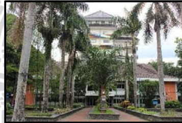
Gambar 4.150 Tampak depan Gedung Utama FIB
