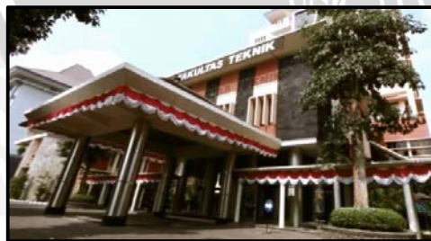
Gambar 4.203 Kondisi visual Gedung Dekanat Fakultas Teknik Sumber: R. Hafinudin, 2016
