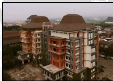
Gambar 4.199 Kondisi visual Gedung FISIP Sumber: R. Hafinudin, 2016
