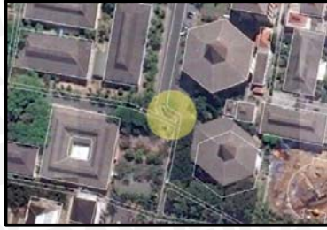
Gambar 4.161 Tampak Atas lokasi Node 5 Sumber: Google Earth, 2016
