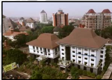
Gambar 4.197 Kondisi visual Gedung FIA (lama) Sumber: R. Hafinudin, 2016
