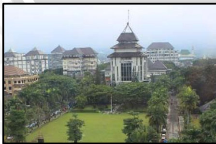
Gambar 4.187 Kondisi visual Gedung rektorat
