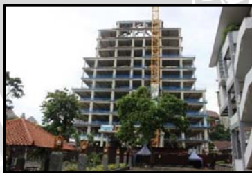
Gambar 4.212 Kondisi visual gedung FIA (baru)
