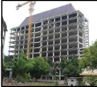
Gambar 4.205 Kondisi visual Gedung Fak. Kedokteran (baru)
