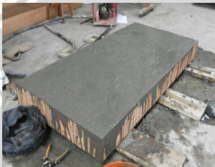
Proses pengecoran benda uji
