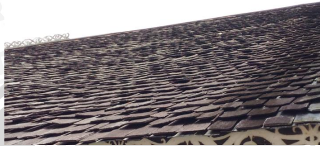
Gambar 4.222 Kondisi Atap Rumah Lamin Adat Desa Pampang
