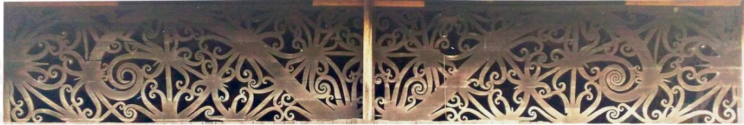
Gambar 4.212 Kondisi Fisik Ukiran/Ornamen pada Dinding Eksterior Bagian Atas
