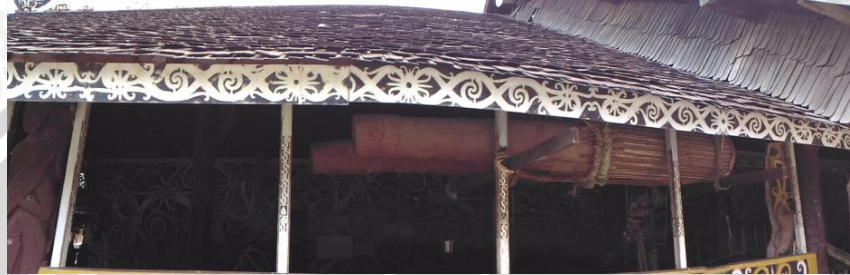
Gambar 4.102 Shading Device dan Frame Void pada Dinding Eksterior Ruang Utama
