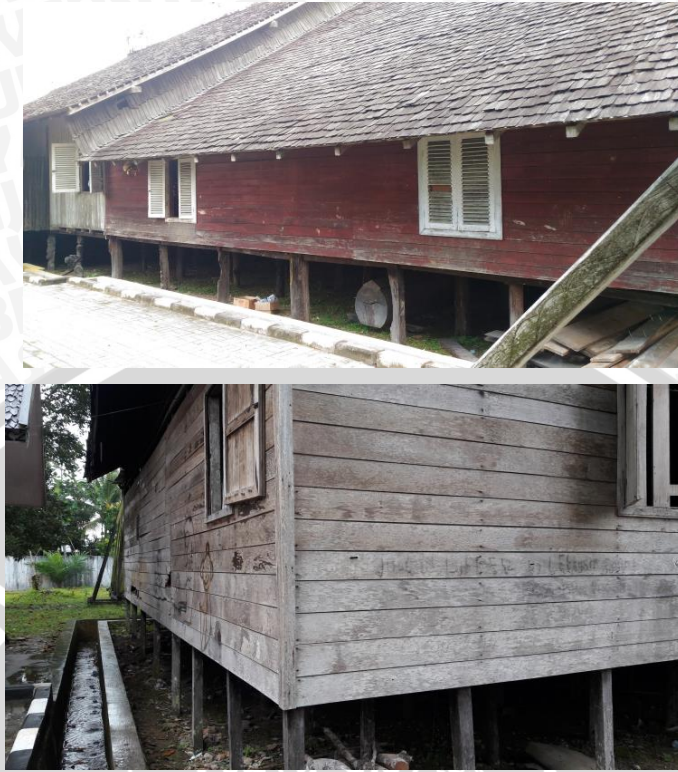
Gambar 4.102 Kondisi Fisik Dinding Eksterior Bagian Belakang Bangunan
