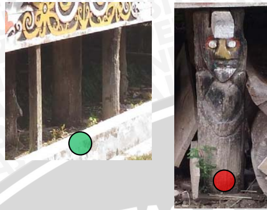
Gambar 4.12 Peletakan & Kondisi Tiang-Tiang Panggung Sisi Utara & Selatan
