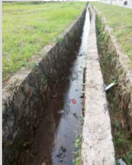
Gambar 4. 14 Kondisi drainase tapak Sumber: Dokumentasi Pribadi
