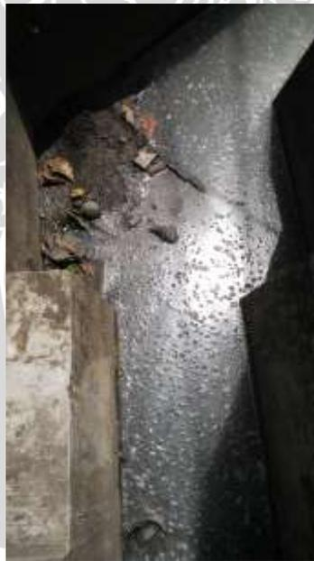
Gambar 4.1 Sedimentasi Pada Saluran Sigura-gura
