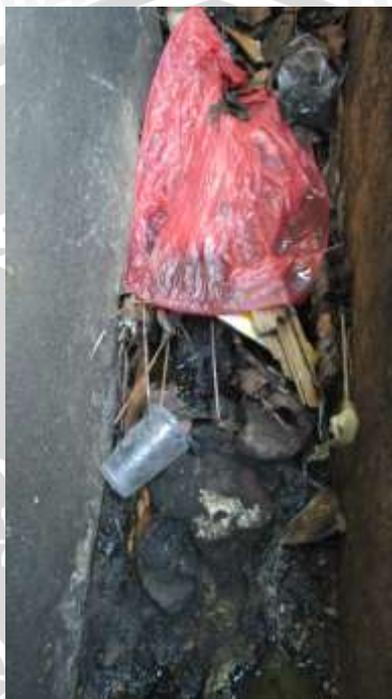
Gambar 4.2 Penumpukan Sampah Pada Saluran Sigura-gura
