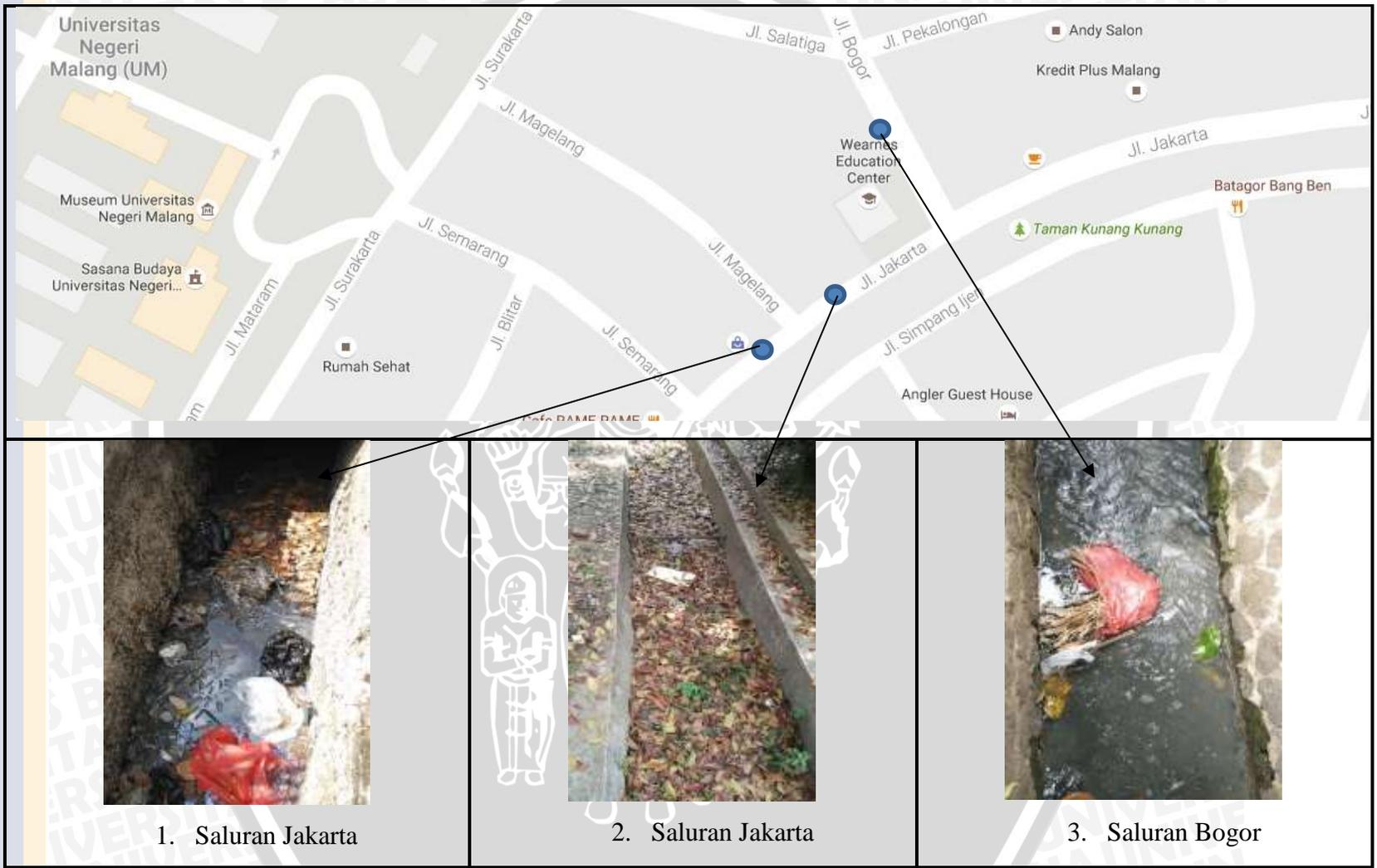
Gambar 3.6 Sedimentasi dan Penumpukan Sampah Pada Saluran Drainase Eksisting
