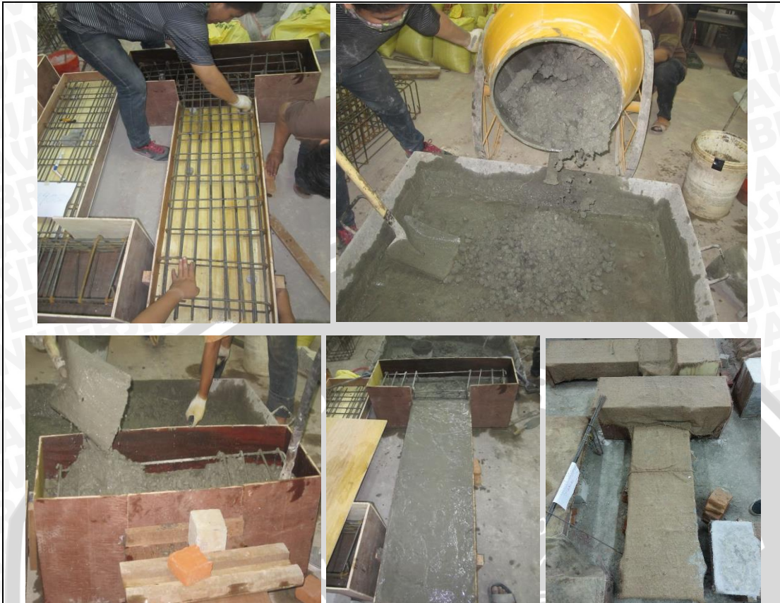
Pengecoran Spesimen Dinding Geser
