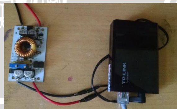
Gambar 3.7 Pemasangan Modul dengan PoE injektor
