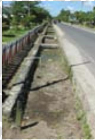
**Gambar 4.25 Saluran Sekunder pada *Catchment Area* 118 (Jalan Cilik Riwut)**
