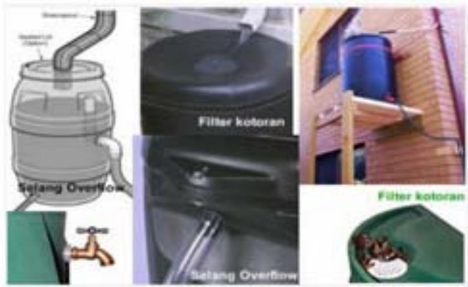
**Gambar 2.13** Komponen *Rain Harvesting* pada Bak Penampungan
