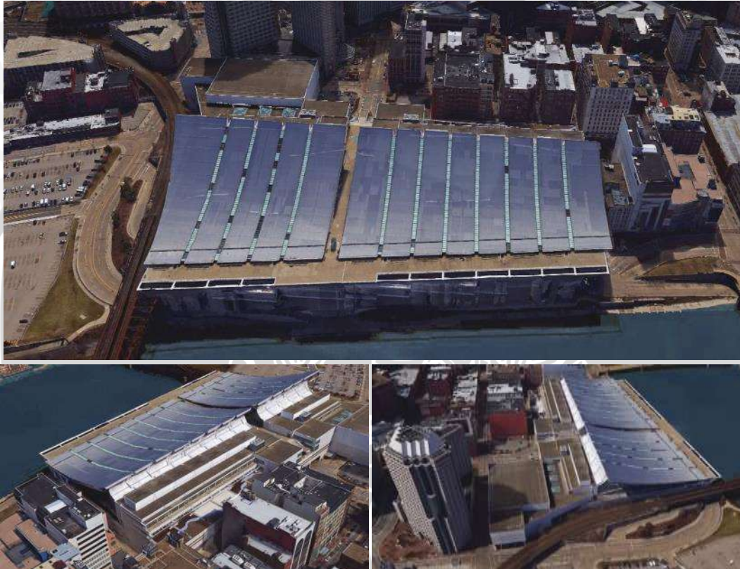
Gambar 2.25. Struktur tenda pada atap yang memberikan kekontrasan bentuk pada bangunan
