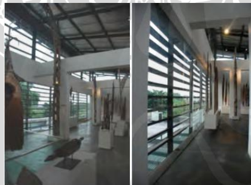
Gambar 2.38. Kisi-kisi pada Gedung DUA8 Sumber: Meiliana (2010)
