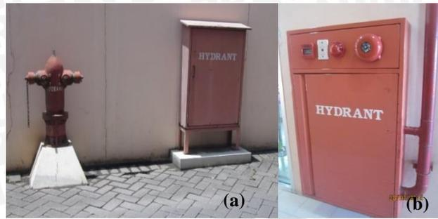
**Gambar 4. 5 Instalasi Hidran Halaman (a) dan Instalasi Hidran Gedung (b) Plaza Araya**
