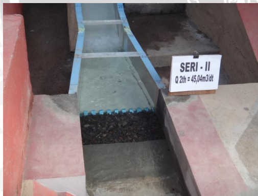
Foto 29. Kondisi Aliran pada Stilling basin Q_{2th}
