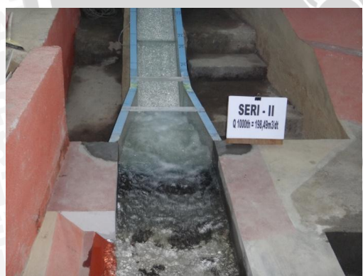
Foto 35. Kondisi Aliran pada Stilling basin Q_{1000th}
