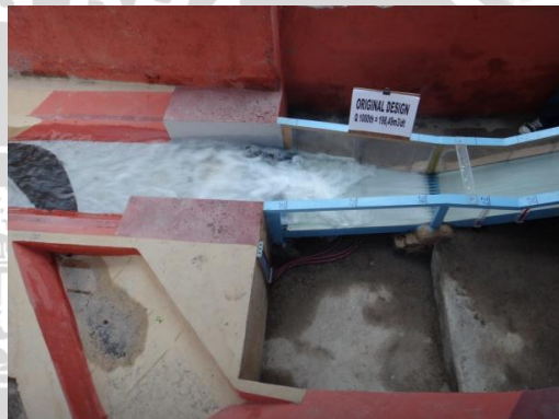
Foto 16. Kondisi aliran pada Peredam Energi
