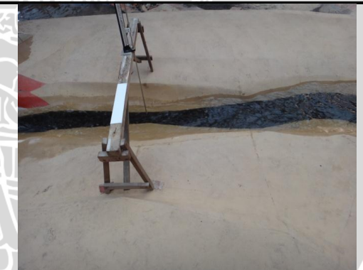
Foto 24. Kondisi aliran pada Sungai Hilir
