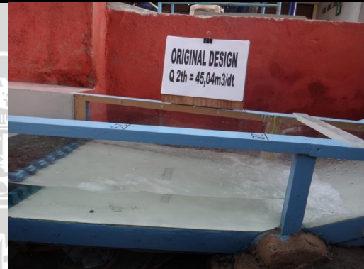
Foto 4. Kondisi aliran pada Peredam Energi
