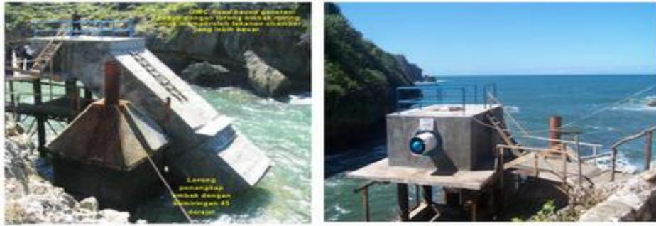
Gambar 2.13 Pembangkit Listrik Tenaga Gelombang Laut Sistem OWC di Pantai Parang
