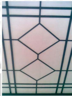
Gambar 2.8 Plafon dengan bingkai rangka kayu. Sumber: Latief (2009)
