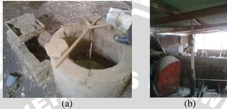
Gambar 4. 5 Perangkat Digester Biogas
