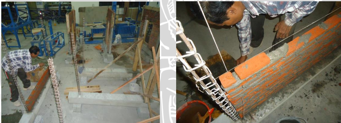
Gambar 4.1. Proses awal pengerjaan dinding
