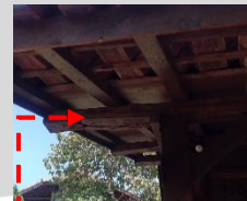
Sambungan rangka atap bangunan
