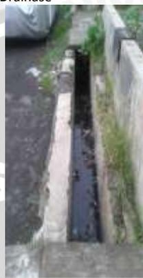
Panjang drainase yang mengelilingi rumah susun yaitu sepanjang 132 meter. Kondisi saluran drainase tersebut buruk karena terdapat penyumbatan pada saluran yang disebabkan oleh sampah dan benda lainnya sehingga fungsi saluran drainase menjadi tidak optimal dan kondisi fisik yang tidak baik arena terdapat kerusakan di sisi bangunan drainase tersebut.
