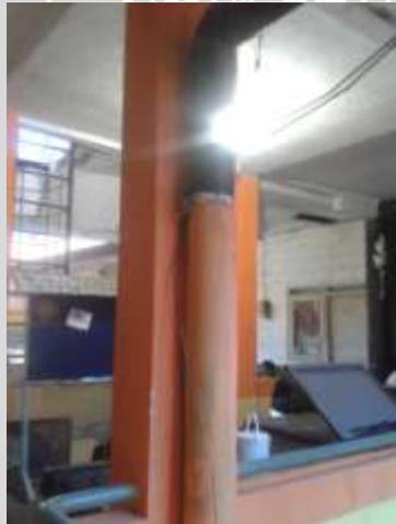
**Gambar 4.16 Saluran pembuangan air hujan**
