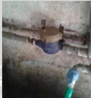
**Gambar 4.11 Meteran air untuk jaringan air bersih**
